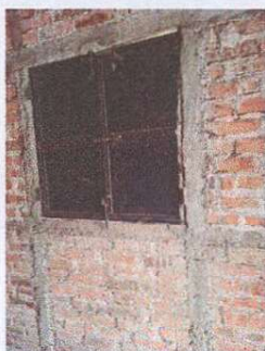
Foto1: Sustrucion de Ventana en Cocina
