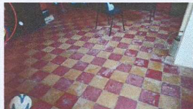
Foto2: Sustrucion de Piso en direccion
