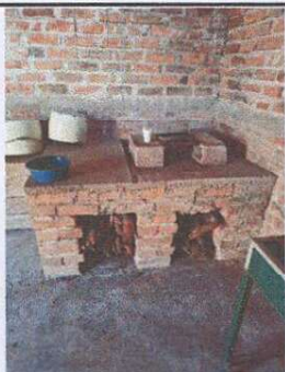
Foto 3: Sustrucción de estufa rural completa.
