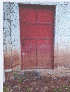
Foto 4: Mantenimiento a puerta de metal
